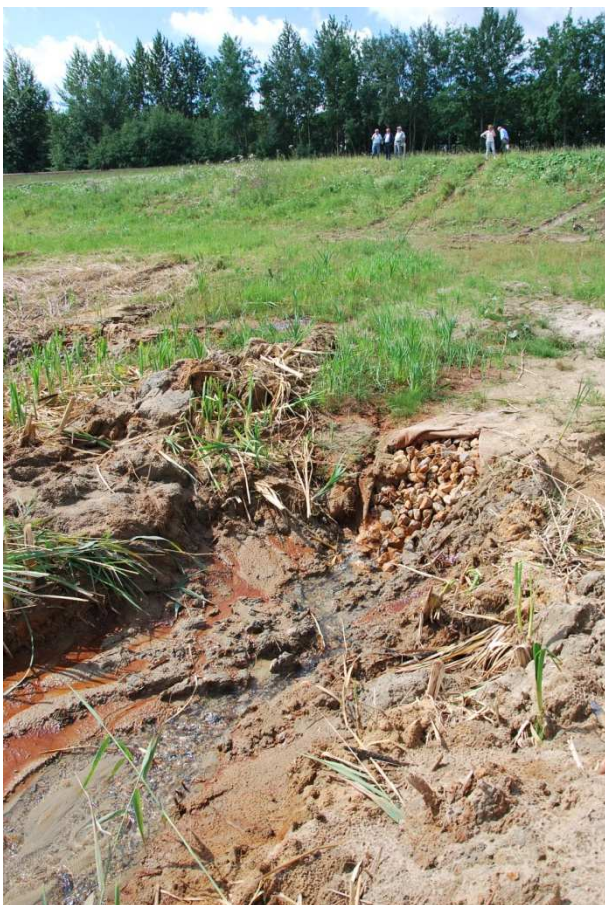
Rys. 11. Wypływ z narożnika SE wyrobiska (fot. K. Polak, 16.07.2015)
